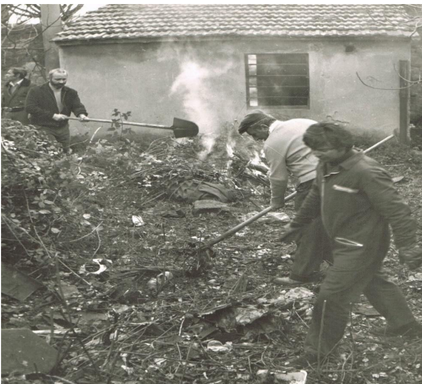
PRIMI LAVORI DI BONIFICA AMBIENTALE NELL'AREA DEGLI EX LAVATOI. PROVVISI DI PALE E FORCONI GLI AMICI RENZO FABERI, GIORGIO GIORGETTI E ROMANO GELLI IN PRIMO PIANO
